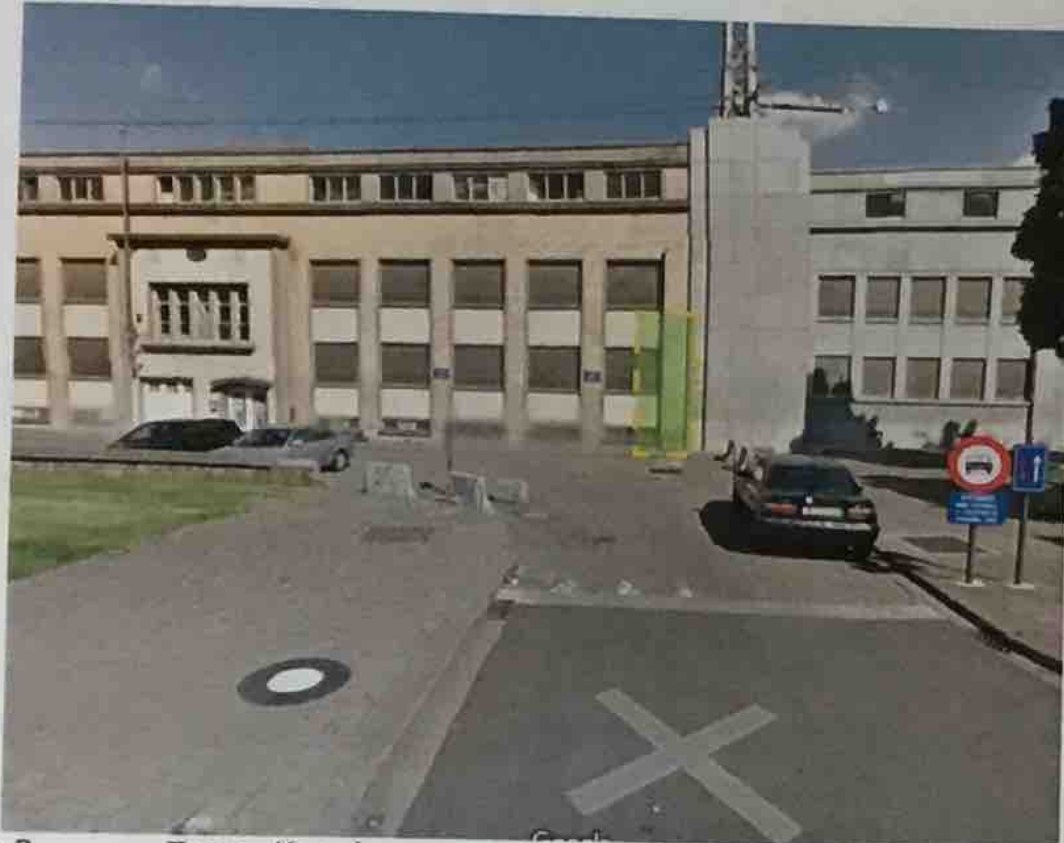
Figure 3 Zone d'aménagement en surface, rue du Progrès (Puits P6)
