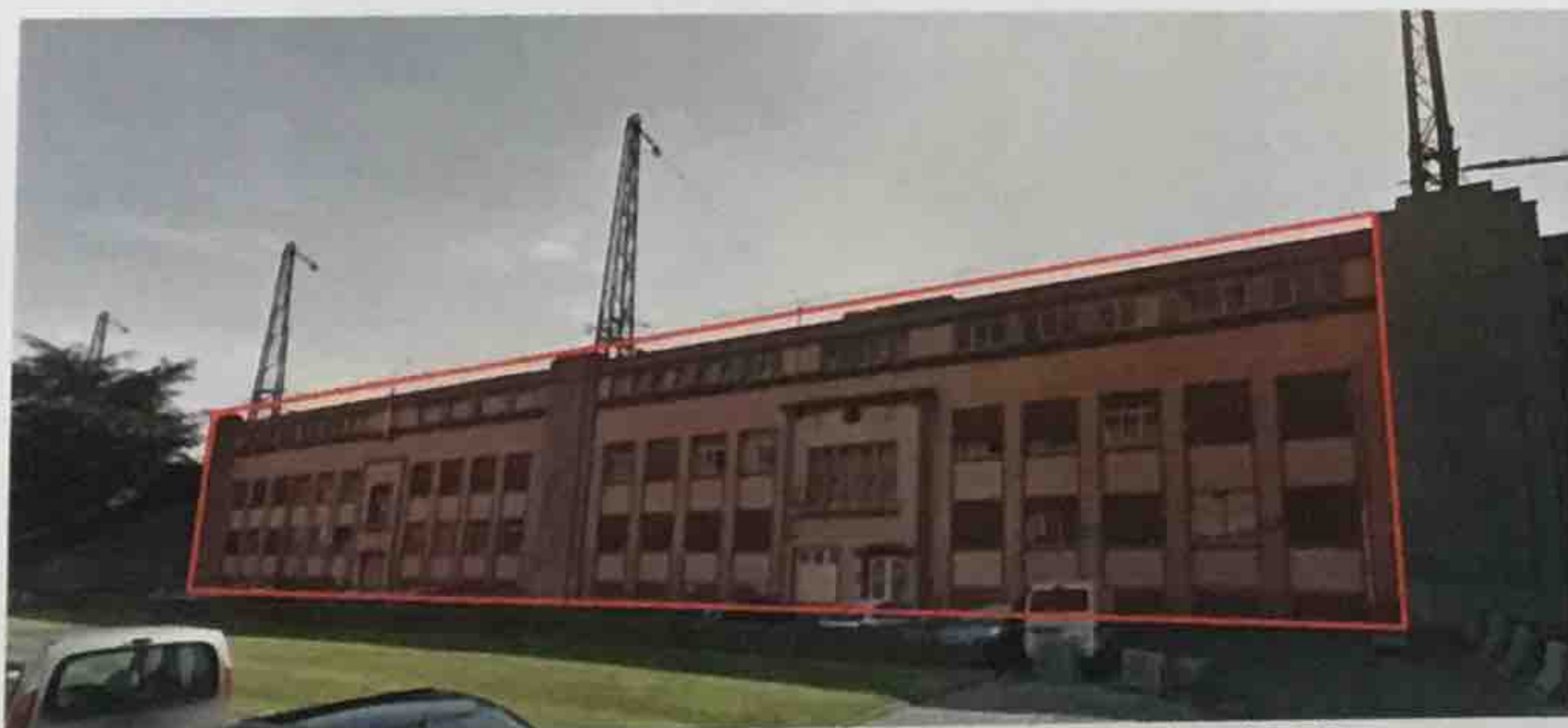
Figure 10 Bâtiment « Medical Centre », à démolir
